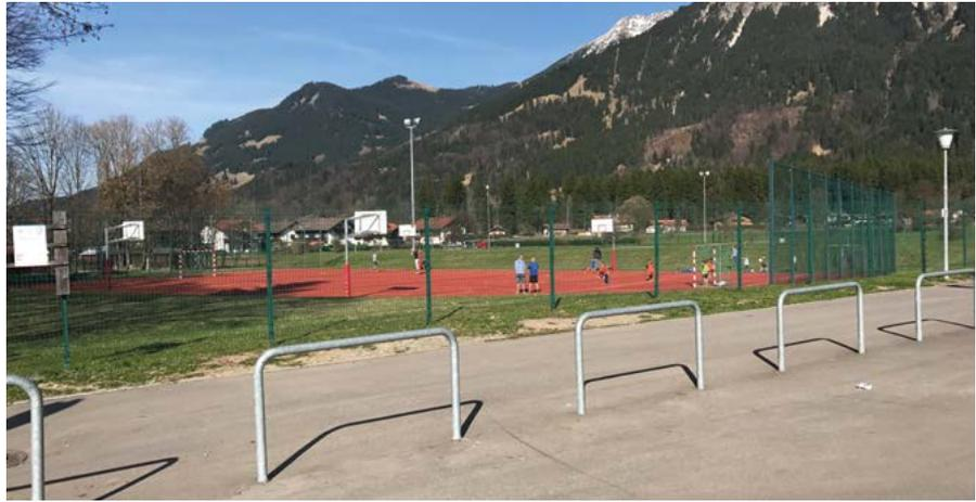
Rohrbügel aus Stahlrohr Ø 60 x 2,5 mm
